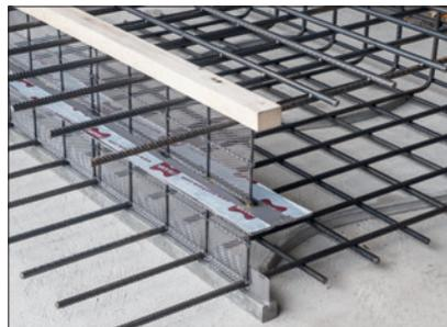
Stremaform® Abschalelement mit integriertem beschichtetem Fugenblech als Wassersperre
